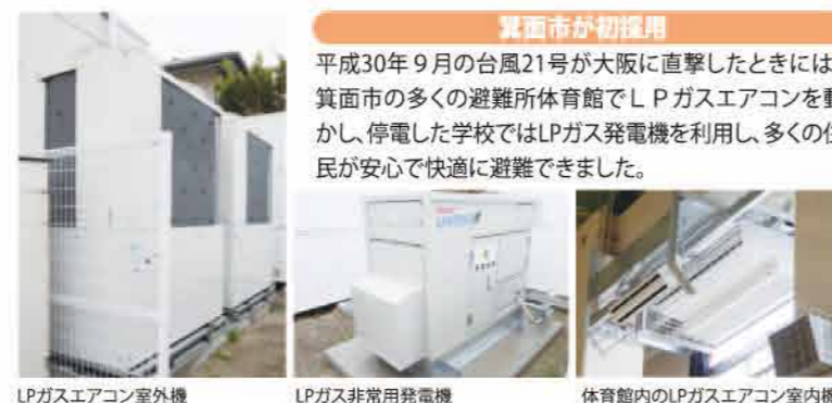
LPガスエアコン室外機 LPガス非常用発電機 体育館内のLPガスエアコン室内機
