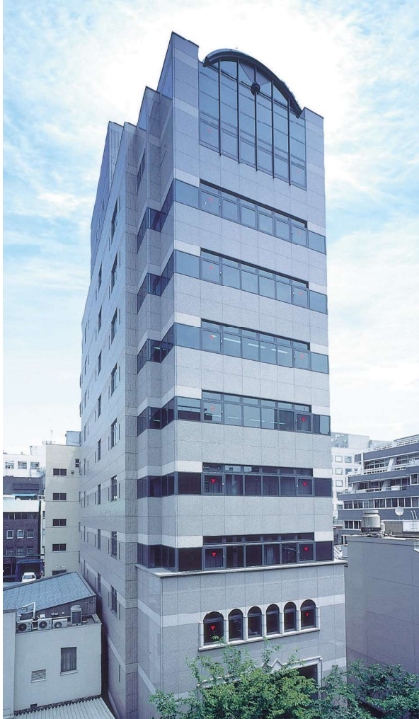
丸善道修町ビル Maruzen Doshomachi Building
